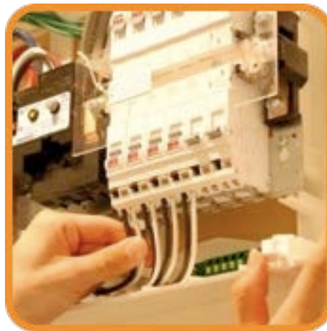
電線と機器端子の確認
