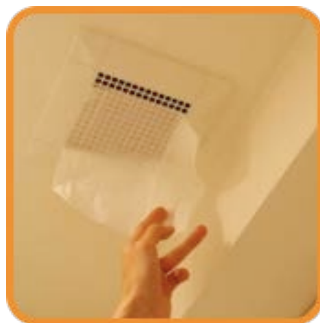
トイレ換気扇の動作確認
