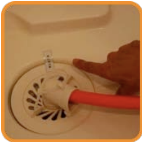
洗濯パンの溢れ確認 (1)
