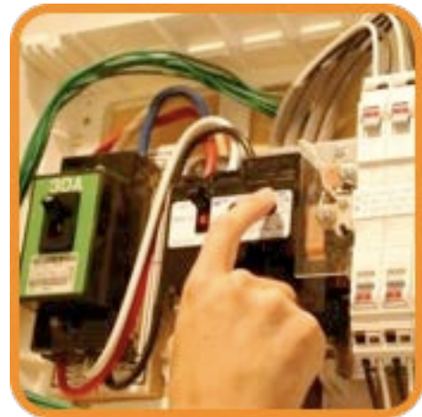
漏電ブレーカーのテスト
