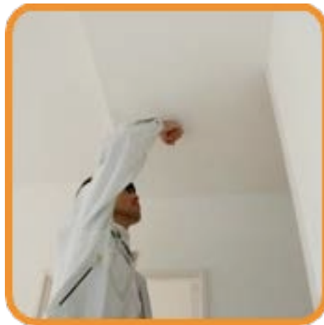
天井下地の強度確認
