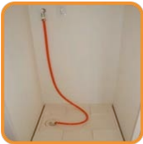
洗濯パンの溢れ確認 (2)
