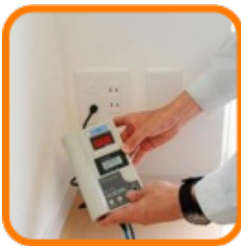
左：受信機によるテレビ配線の確認 右：計測器によるテレビ配線の確認
