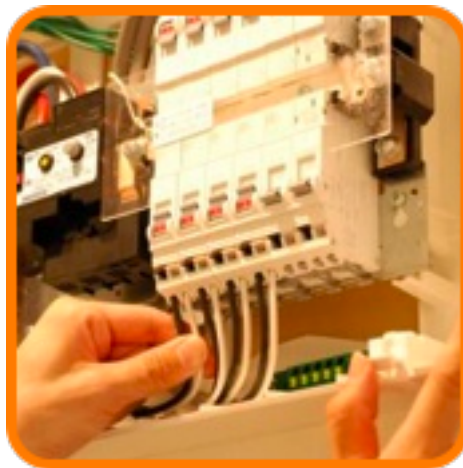
電線と機器端子の確認
