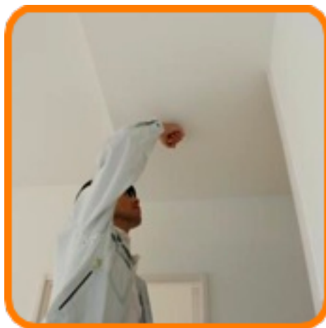
天井下地の強度確認
